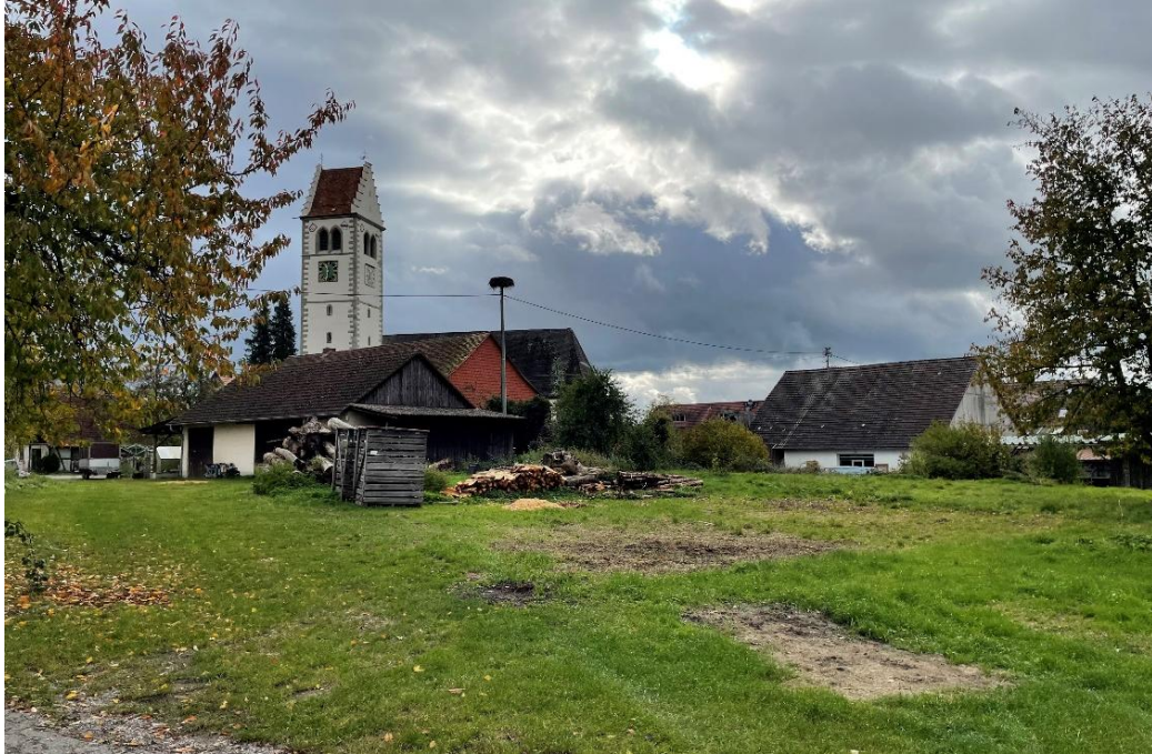
Blick von Westen in das Plangebiet
