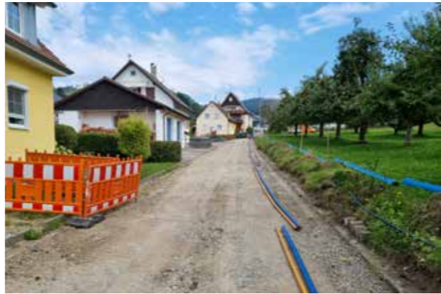
09.2021 - 04.2022 | Sanierung der Wasserversorgung & Neuverlegung Glasfaser in der Schützenstraße
